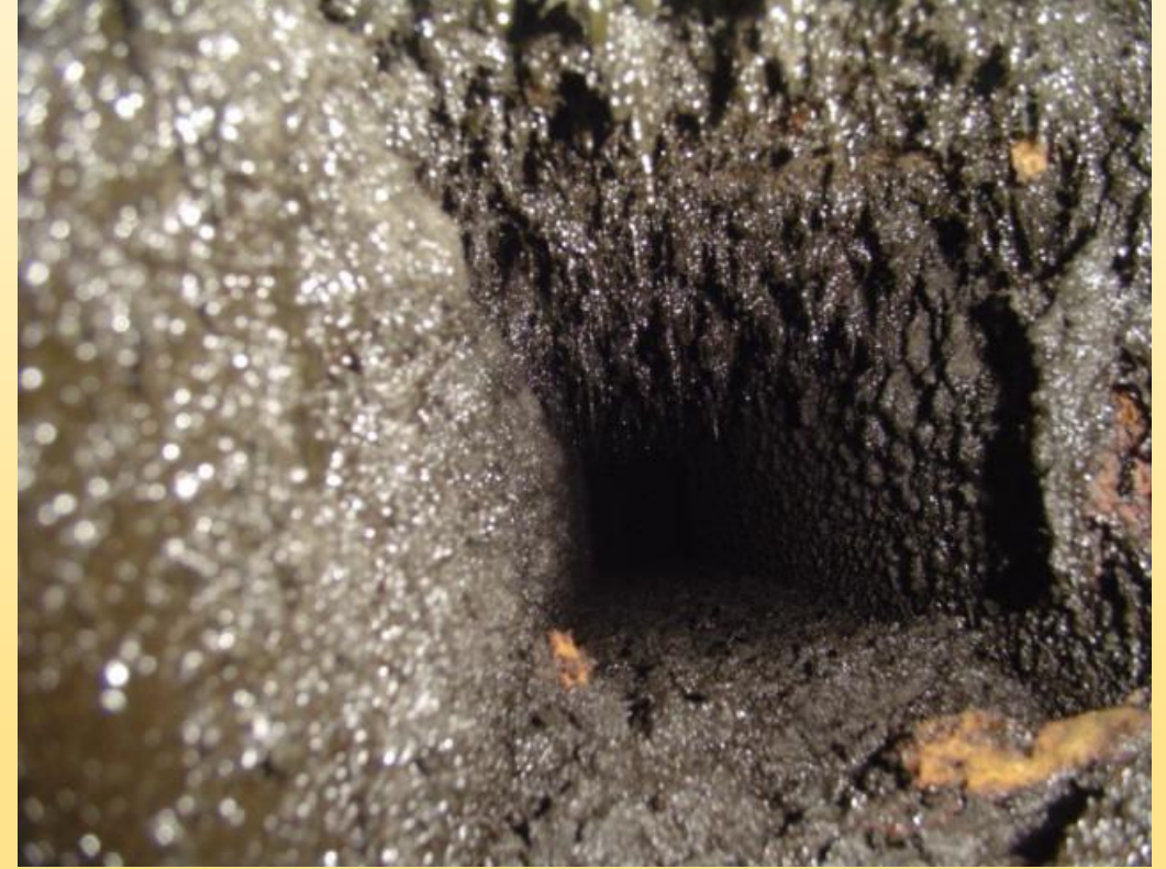
Gaz yakan bir hamburger ızgarasının baca kanalında yağ birikimi
